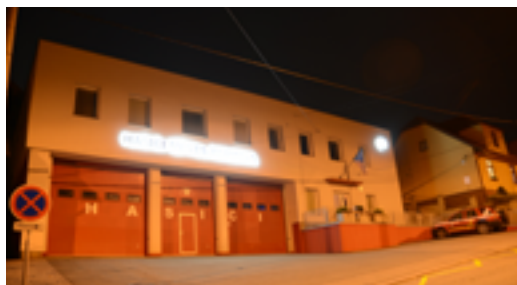
V roce 2018 rekonstruovaná hasičská zbrojnice
