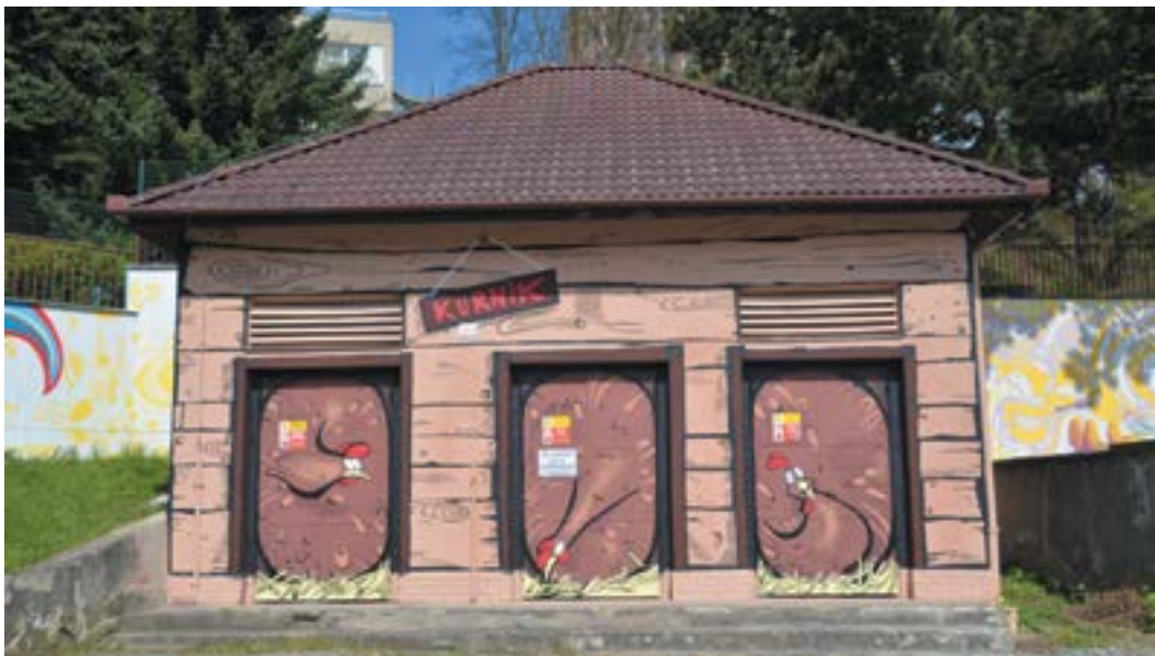
EG.D navázalo na nově zrekonstruovanou opěrnou zídku pod MŠ P. Jilemnického novou fasádou elektrorozvodny, jenž je dílem z Ateliéru Malujeme jinak od Lukáše Veselého
