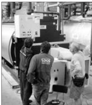
Servisní technik firmy LOOS nastavuje regulátor plynu na právě nově spuštěném kotli v kotelně u nádraží.
