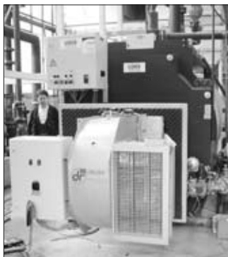
Servisní technik firmy LOOS nastavuje regulátor plynu na právě nově spuštěném kotli v kotelně u nádraží.
