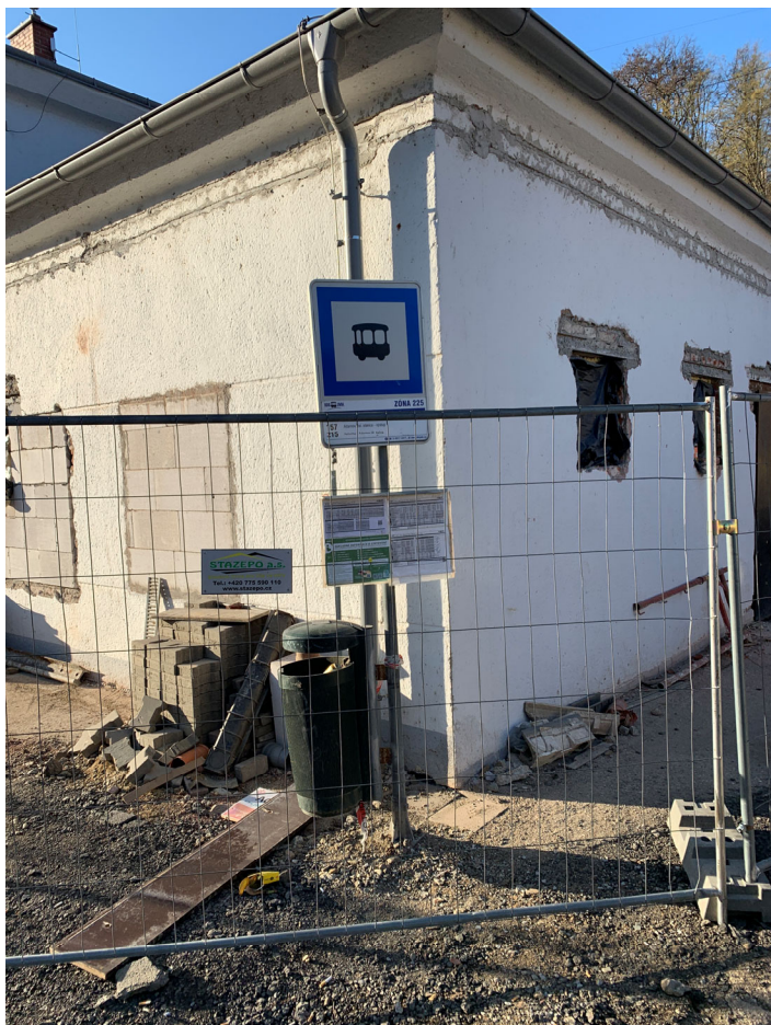
Adamov, železniční stanice (směr Adamov III, točna)
