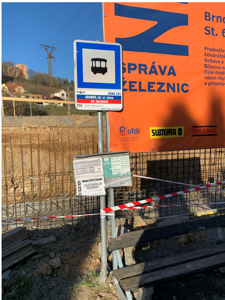
Adamov, železniční stanice, točna (směr Adamov III, točna)
