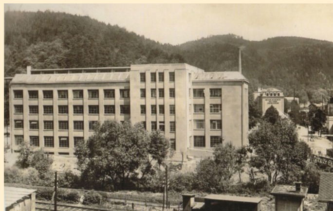
Budova „brzdárny“ v roce 1930
